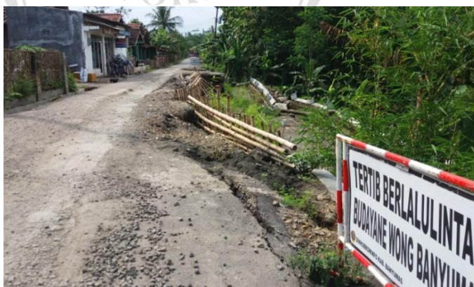
Gambar 1.2. Amblasan pada tepi perkerasan ruas Jalan Banjarparakan Menganti
