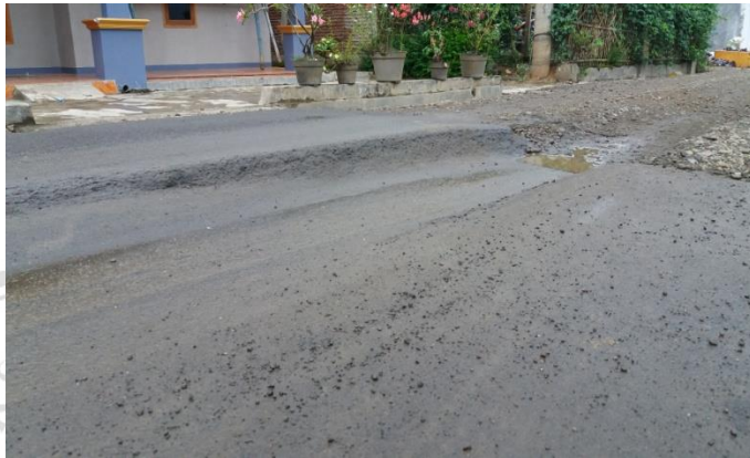
Gambar 1.1. Deformasi pada tepi perkerasan ruas Jalan Banjarparakan Menganti
