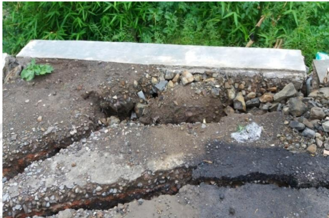
Gambar 1.3. Retakan besar pada tepi perkerasan ruas Jalan Banjarparakan-Menganti
