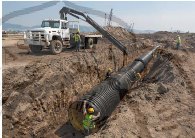
Gambar 2.4 Drainase Bawah Permukaan
