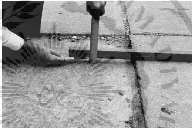
Gambar 2.7 Kerusakan Patahan ( Faulting )
