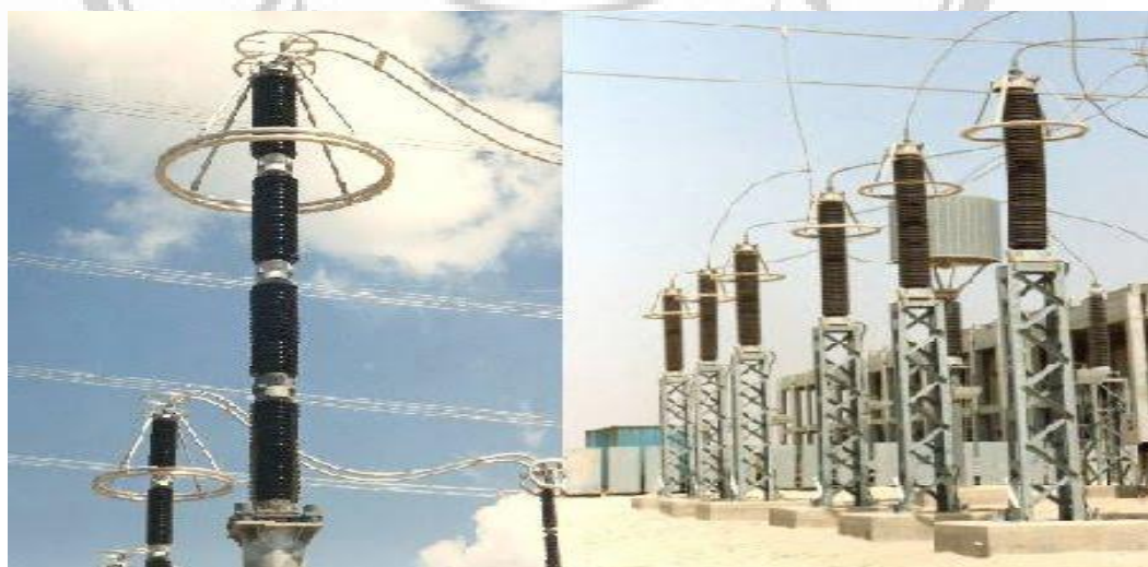
Gambar 2.9 Arrester Seng Oksida
