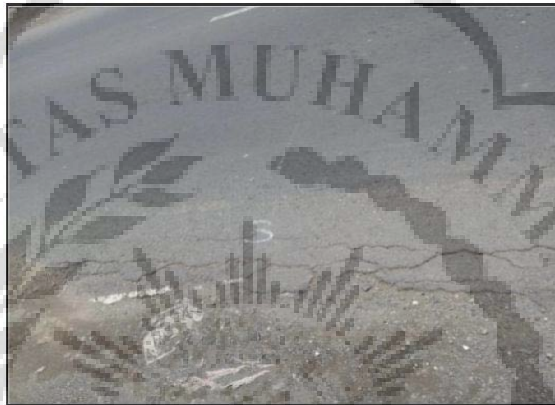
Gambar 2.6 Retak Pinggir
