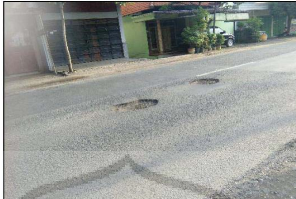
Gambar 2.9 Kerusakan Lubang
