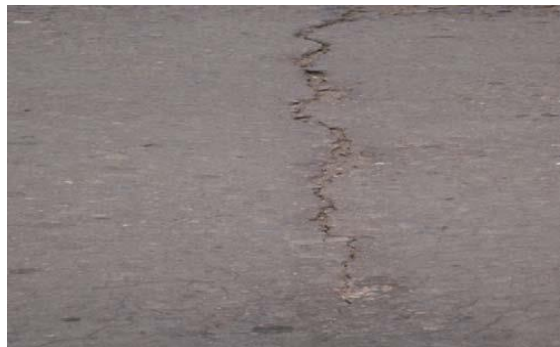
Gambar 2.11 Pinggiran Jalan Turun Sumber : Bina marga no.03/MN/B/1983
