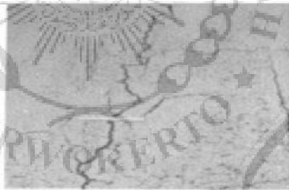
Gambar 2.6 Retak Memanjang
