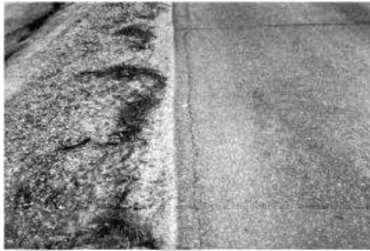
Gambar 2.11 Retak tepi
