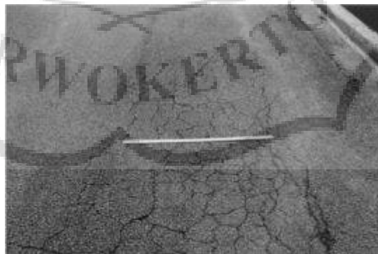
Gambar 2.5 Retak kulit buaya
