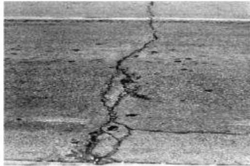
Gambar 2.12 Retak refleksi sambungan
