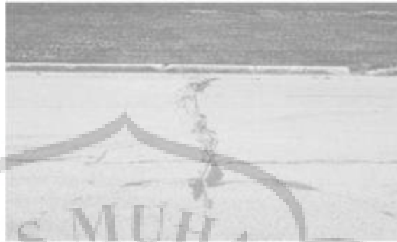
Gambar 2.14 Retak memanjang/melintang
