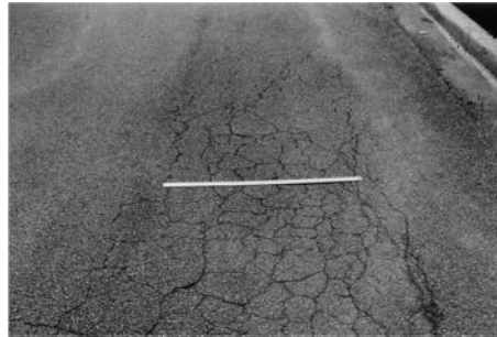
Gambar 2.5 Retak kulit buaya
