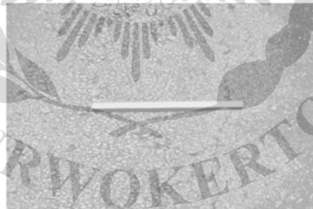
Gambar 2.23 Pelapukan dan pelepasan butir
