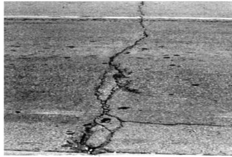
Gambar 2.12 Retak refleksi sambungan
