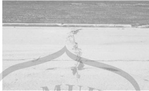
Gambar 2.14 Retak memanjang/melintang
