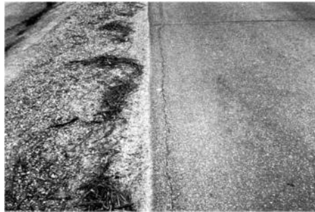
Gambar 2.11 Retak tepi
