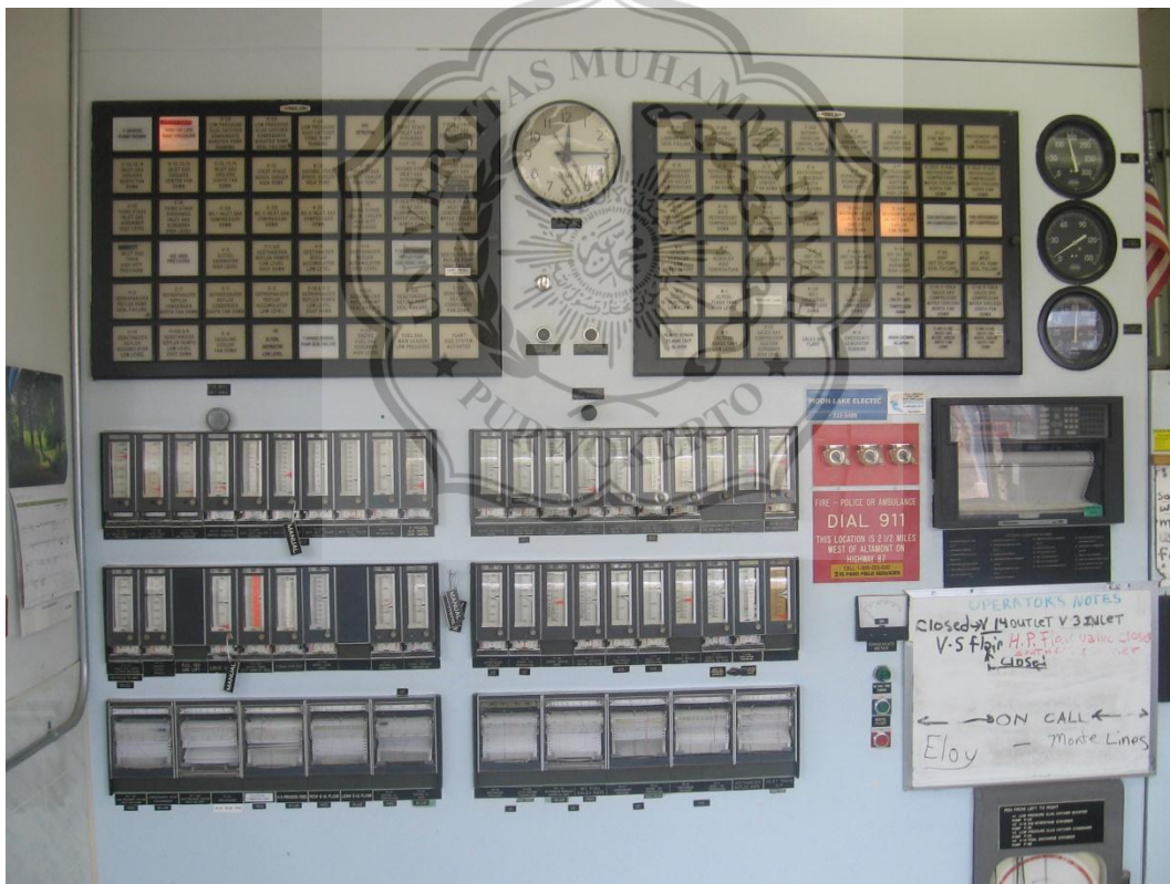
Gambar 2.4 Sistem kontrol pneumatic terpusat di control room
