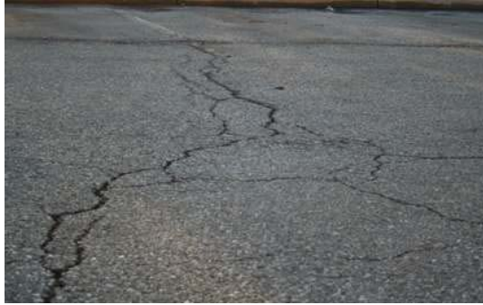
Gambar 2.11 retak bekelok-kelok
