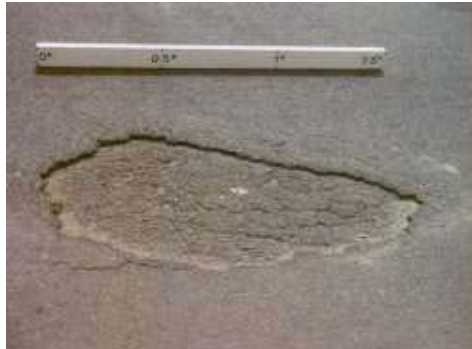
Gambar 2.23 Penglupasan ( delamination )
