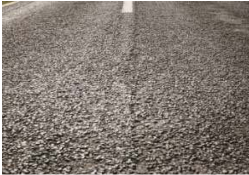
Gambar 2.22 agregat licin akibat aus
