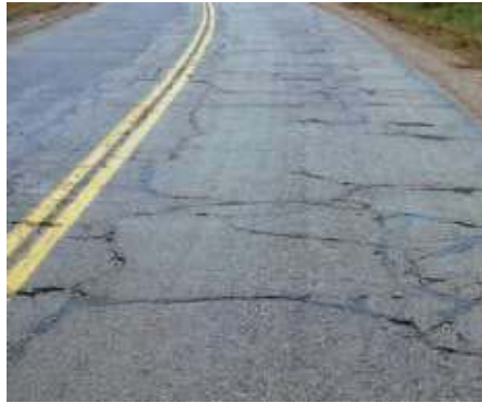
Gambar 2.15 Retak blok.
