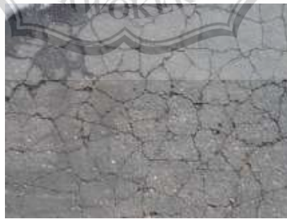
Gambar 2.14 retak kulit buaya.
