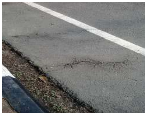
Gambar 2.18 Retak Pinggir
